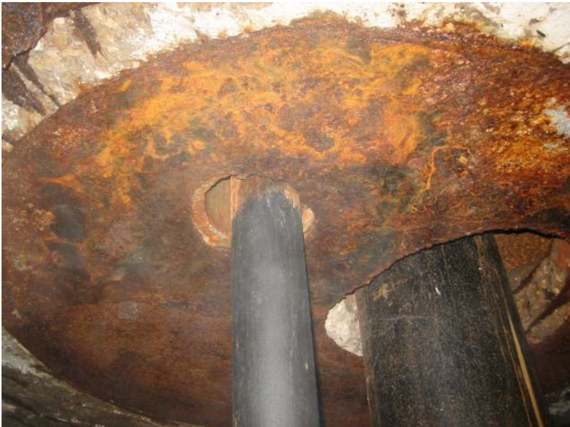
Att. 4. Nīcas ūdenstornņa tvertnes apakša
