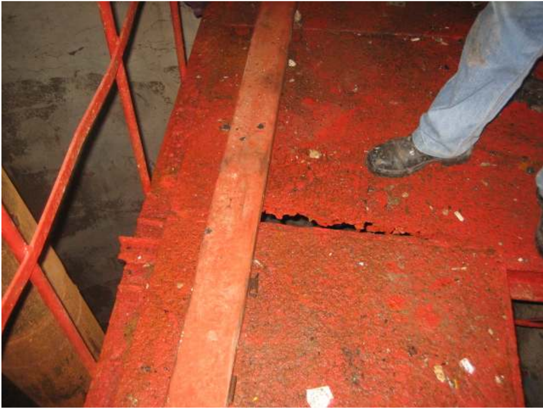
Att.7. Nīcas ūdenstorņa kāpņu augšējā platforma, pie tvertnes.
