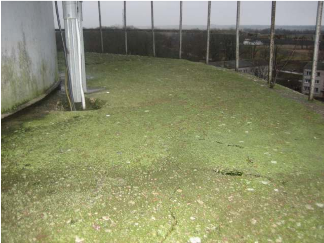
Att. 9. Betona laukums pie ūdenstorņa tvertnes
