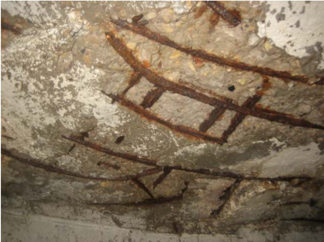
Att. 5. Nīcas ūdenstorņa tvertnes betona pamatne
