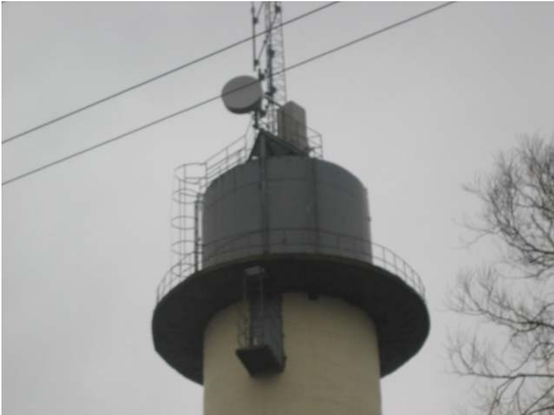
Att.1. Nīcas ciema ūdenstornis
