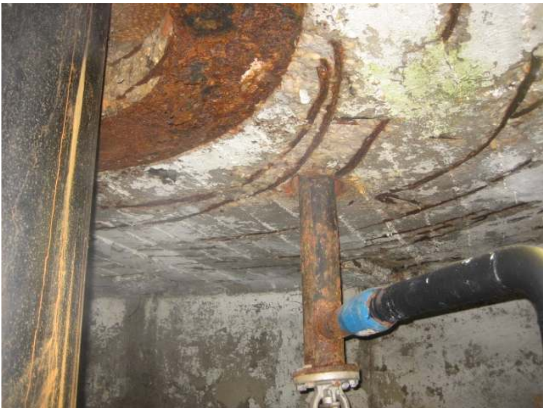
Att. 6. Nīcas ūdenstorņa tvertnes betona pamatne
