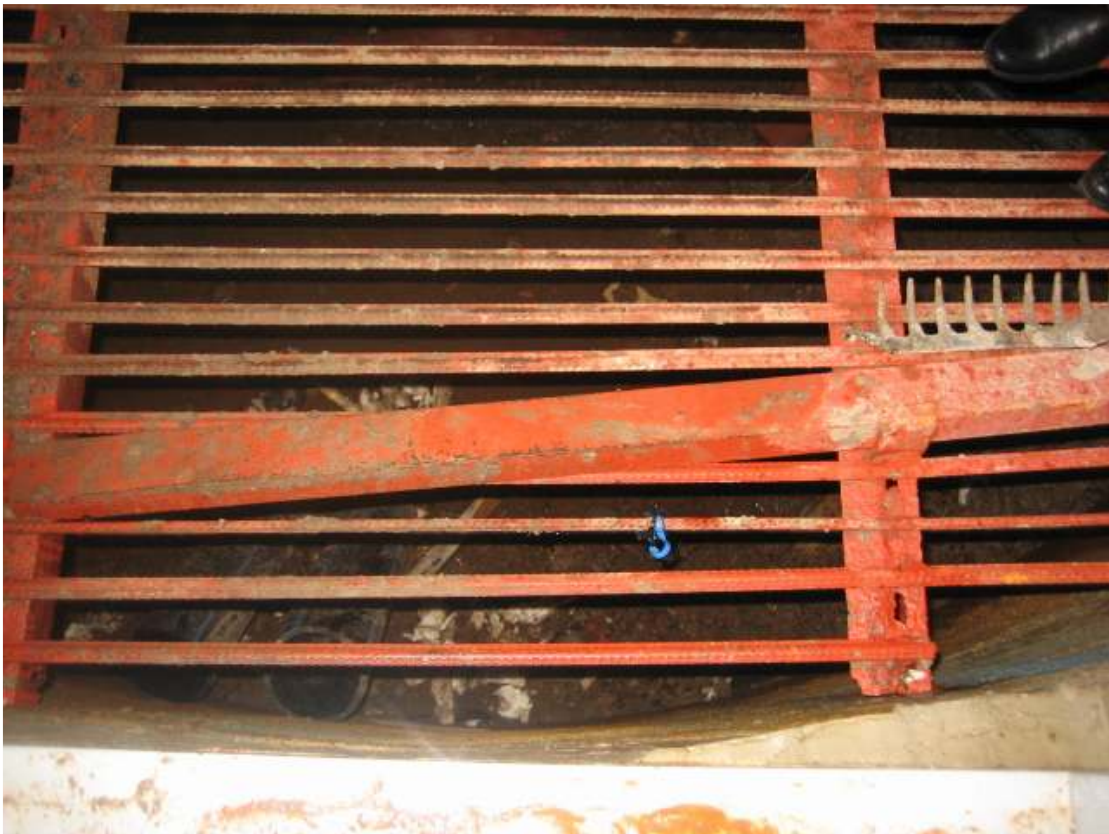
Att. 8. Ūdenstorņa kāpņu platforma pie ieejas
