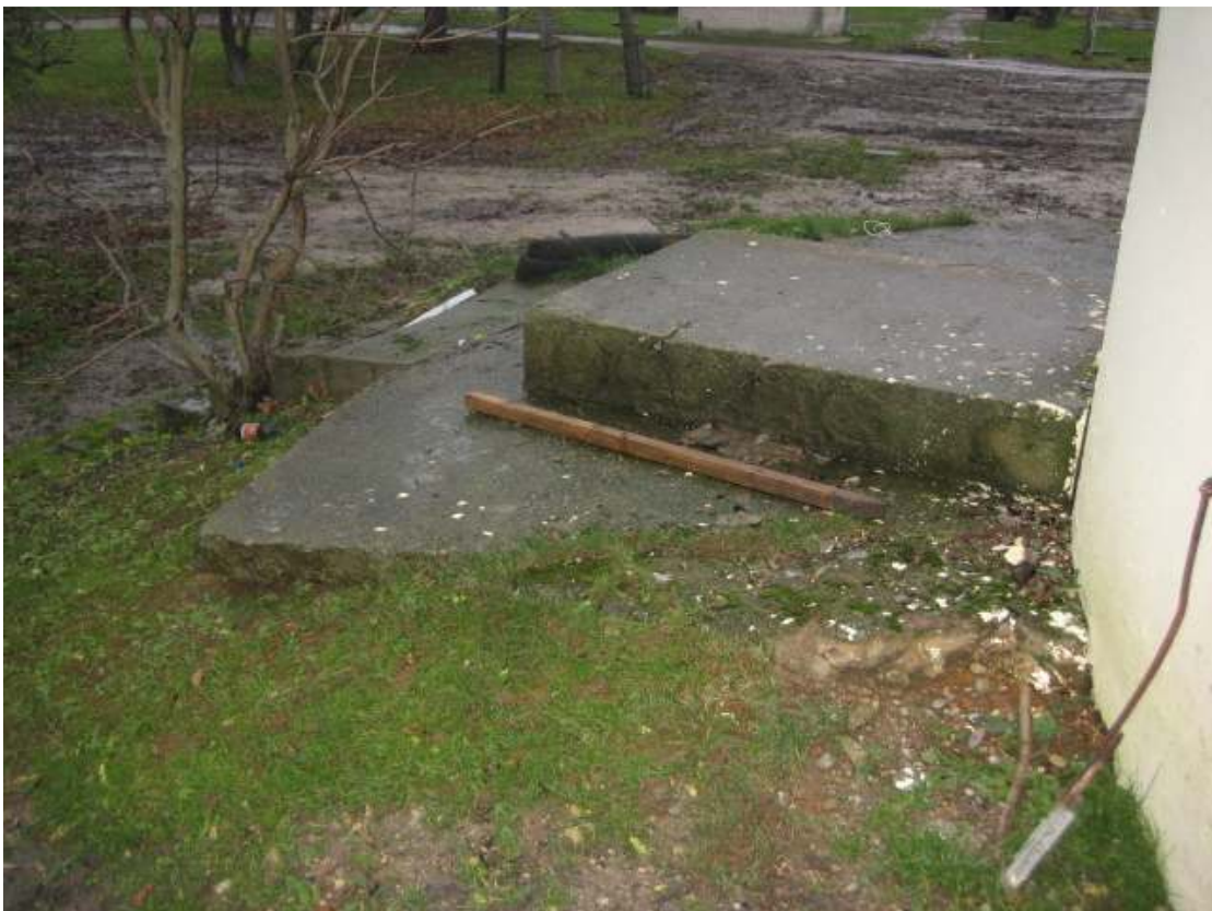
Att.2. Nīcas ūdenstornņa ieejas kāpnes
