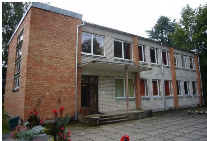
8.attēls: Ēkas fasāde.
