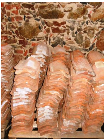
Attēlā: Senie dakstiņi rūpīgi attīrīti, sašķiroti un glīti salikti gaida jumta seguma atjaunošanas darbus.
