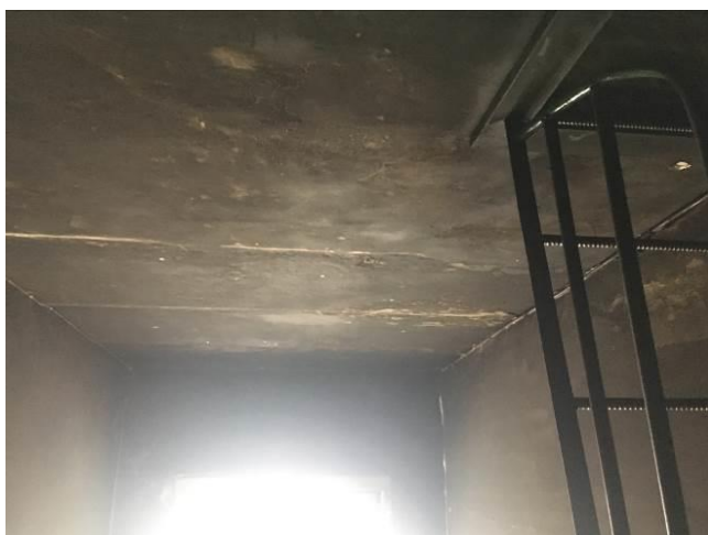
Sienu un griestu konstrukciju un apdares bojājumi.
