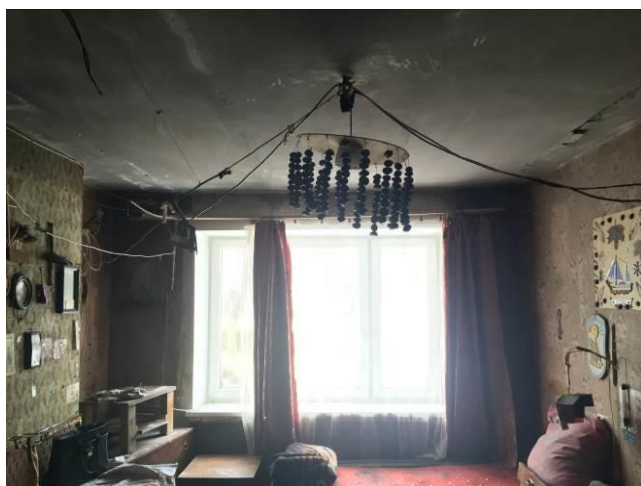
Sienu un griestu konstrukciju un apdares bojājumi.
