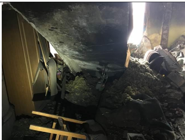
Bojāta pārsegumā instalētā elektroinstalācija.
