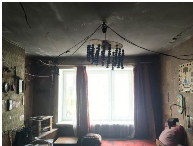
Sienu un griestu konstrukciju un apdares bojājumi.
