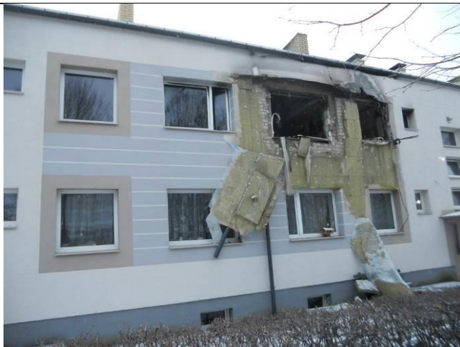
Fasādes siltinājums un apdare.
