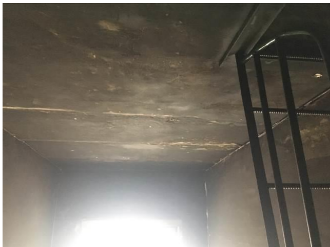
Sienu un griestu konstrukciju un apdares bojājumi.
