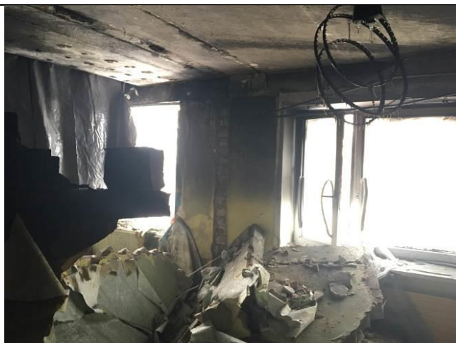
Sienu un griestu konstrukciju un apdares bojājumi.
