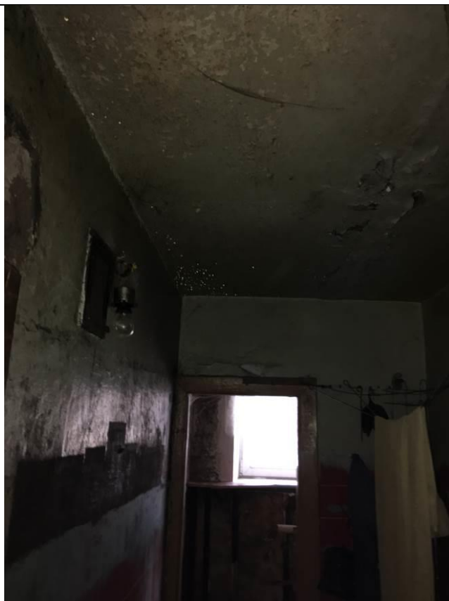
Sienu un griestu konstrukciju un apdares bojājumi.
