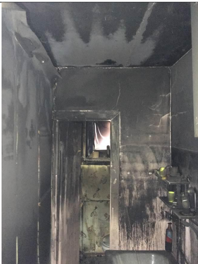
Sienu un griestu konstrukciju un apdares bojājumi.
