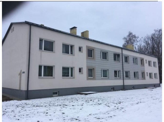
Ārsienas siltinājums un apdare.
