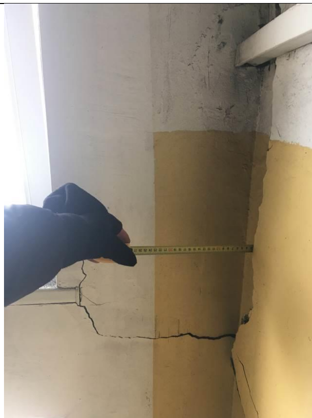
Kāpņu telpas nesošās iekšsienas nobīde 4 cm.
