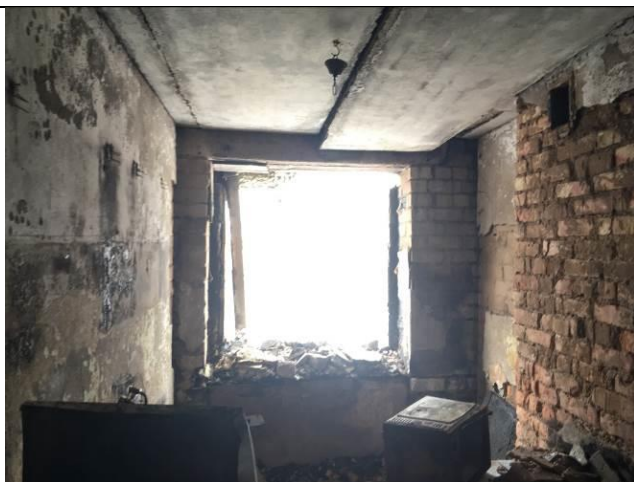
Sienu un griestu konstrukciju un apdares bojājumi.
