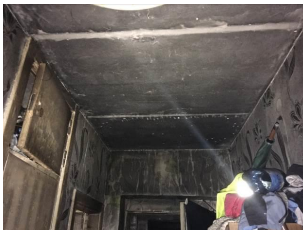
Sienu un griestu konstrukciju un apdares bojājumi.
