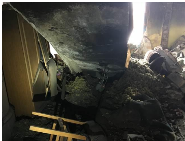
Bojāta pārsegumā instalētā elektroinstalācija.
