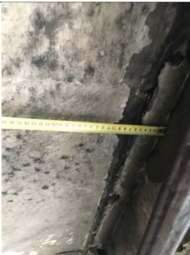
Nesošās ārsienas nobīde no plaknes 10 cm, ko var konstatēt pēc sienas apdares un pārseguma paneļa novietojuma.
